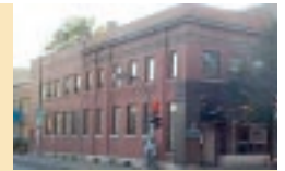
Le nouvel immeuble acquis l'an dernier par CKRL à Québec
